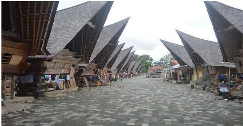
Ruang Terbuka Area Selatan
