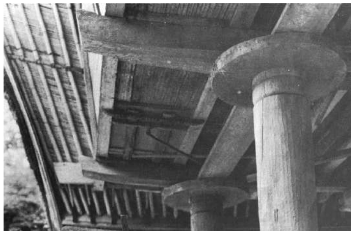
Struktur Tiang dan Balok Lantai
