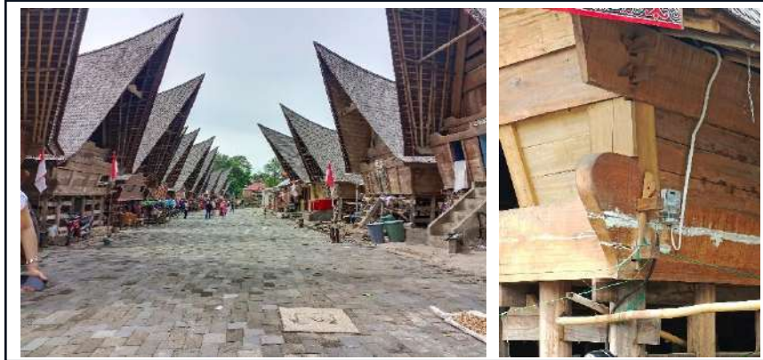
Gambar 4.45 Instalasi listrik luar bangunan Rumah Tradisional Batak Toba Desa Hutaraja
