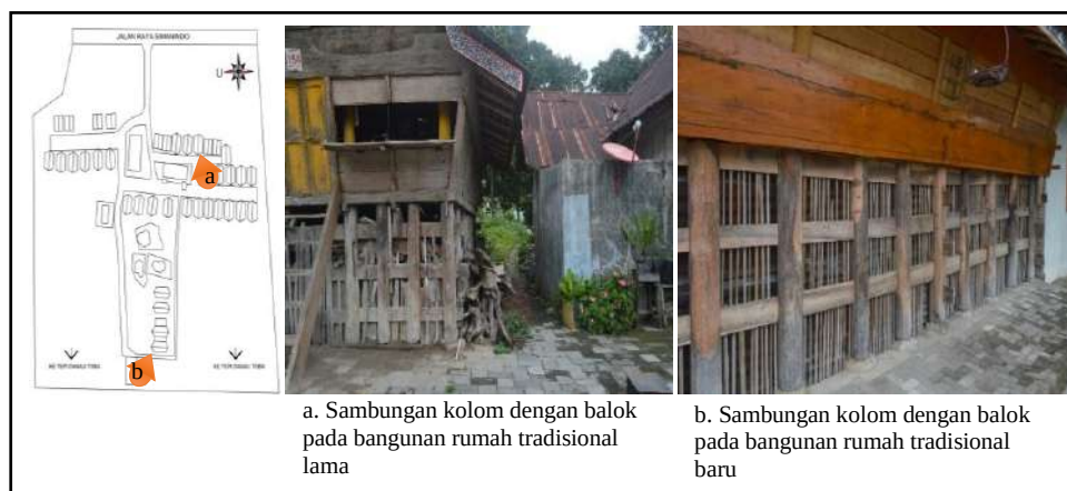
Gambar 4.39 Sambungan kolom dengan balok pada bangunan rumah tradisional lama (kiri) dan rumah tradisional baru (kanan)
