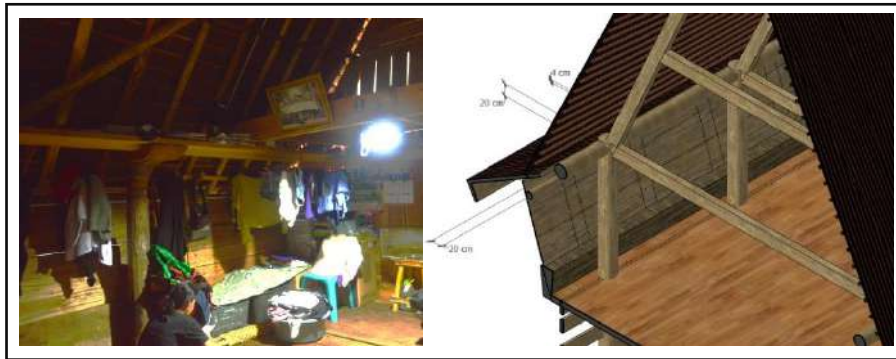
Gambar 5.31 Analisa integritas struktur balok dan rangka atap
